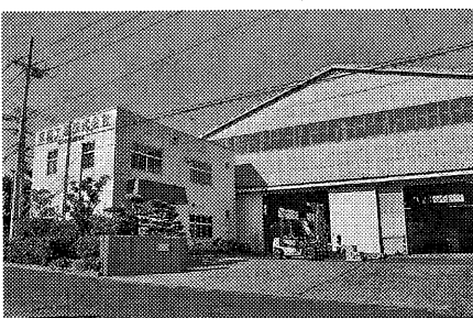
15年版へ移行完了した東和工業の工場
